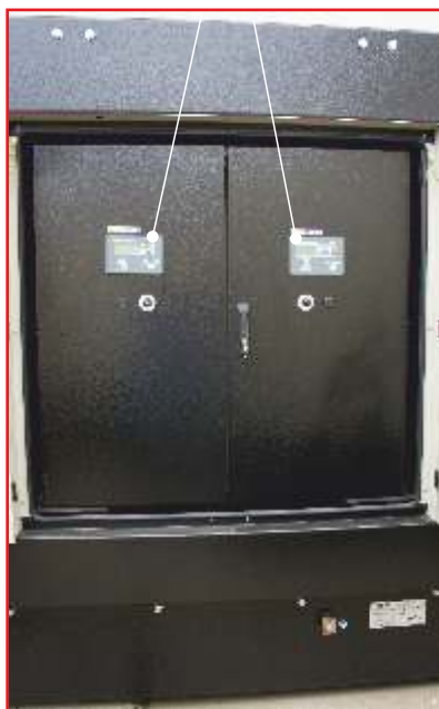
Панели с функцией параллельной работы на базе контроллеров ComAp Intelli Compact (вид снаружи)
