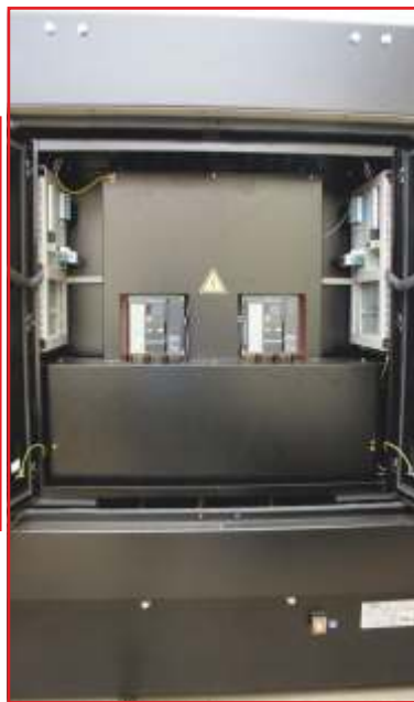
Панели с функцией параллельной работы на базе контроллеров ComAp Intelli Compact (вид изнутри)
